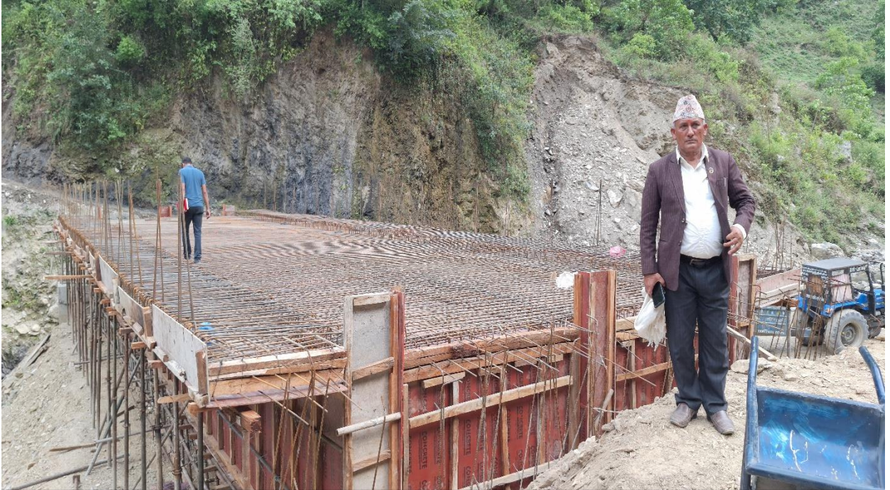
नलगाड नगरपालिका वार्ड नं. ३ मा निर्माणाधीन कैना पुल
