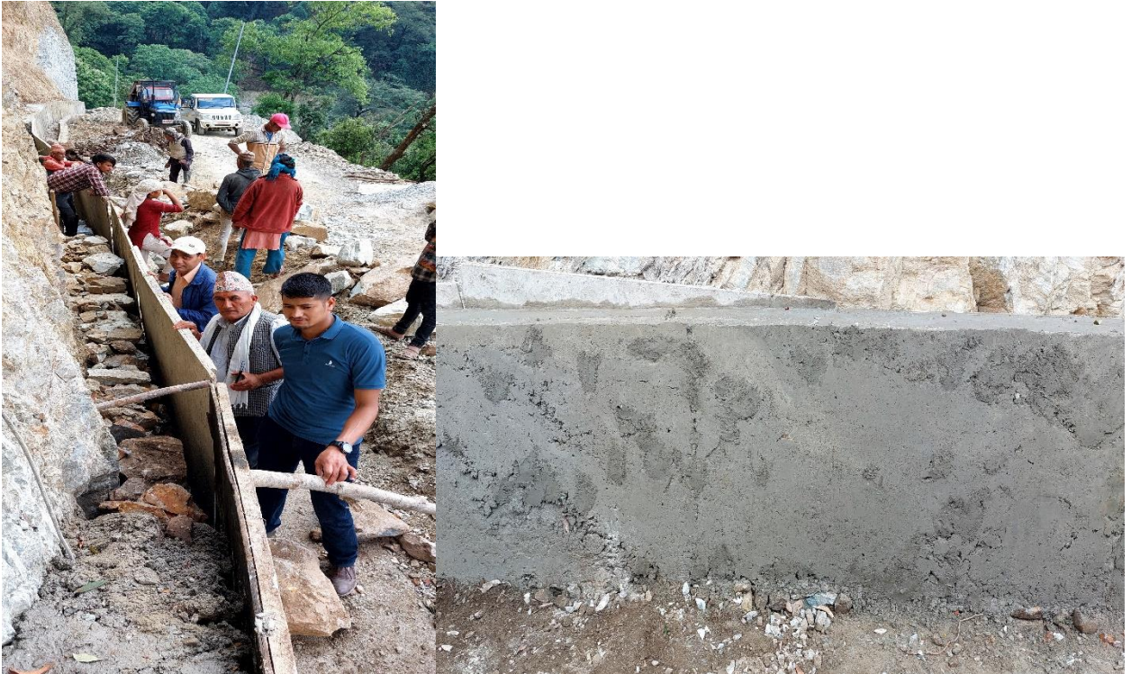
निर्माणाधीन पाँचकाटिया-पाटेखोला सडकको निर्माण हुँदै गरेको Protection Wall
