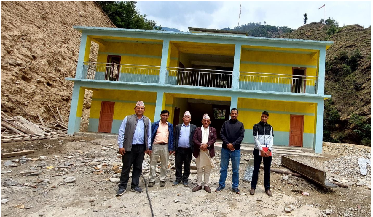
निर्माण सम्पन्न भएको कुशे गाउँपालिका वार्ड नं. ६ स्थित दिपेन्द्र मा.वि. घरङ्गा। भवन निर्माण गर्ने जमीन बनाउन जंगल सहितको पहाड काट्न ठूलो रकम खर्च गरिएको छ
